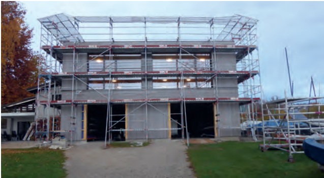
Bootshaus Sursee während des Umbaus, 13. November 2018.
